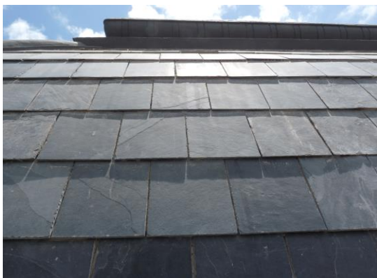
FOTO 102 ASSENTAMENTO DAS ARDÓSIAS COM ARGAMASSA DO TIPO ACIII.
