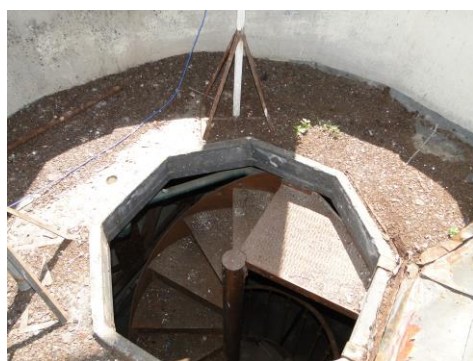
FOTO 136 PISO DO 6º PAVIMENTO – LAJE DE CONCRETO ARMADO, VISTA DA ESCOTILHA DE FECHAMENTO E CAMPANÁRIO
