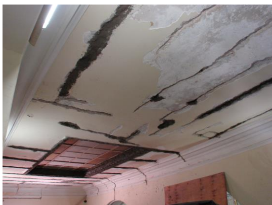
FOTO 80 REINTEGRAÇÃO DO SUBSTRATO DO FORRO – EXTRADORSO E INTRADORSO.
