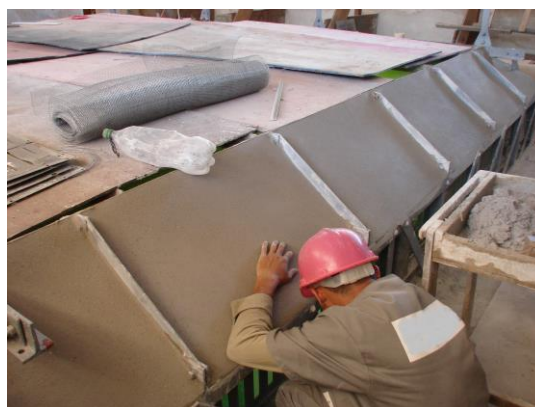
FOTO 80 REINTEGRAÇÃO DO SUBSTRATO DO FORRO – EXTRADORSO E INTRADORSO.
