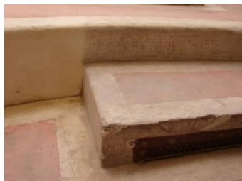
FOTO 87 LIMPEZA, LIXAMENTO E REINTEGRAÇÃO DAS LACUNAS.
