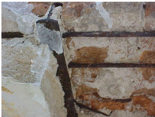
FOTO 122 DESOXIDAÇÃO E PROTEÇÃO ANTICORROSIVA DAS AERRAGENS.
