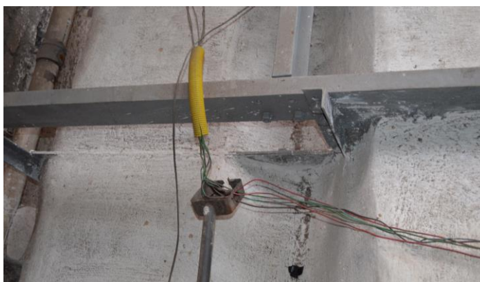
FOTO 50 INSTALAÇÕES FORA DOS PADRÕES TÉCNICOS.
