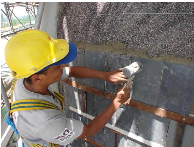
FOTO 101 ASSENTAMENTO DAS ARDÓSIAS COM ARGAMASSA DO TIPO ACIII.
