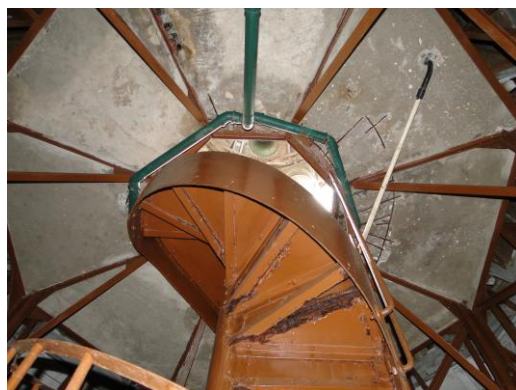
FOTO 135 DETALHE DA ESCADA E PARTE DA ESTRUTURAMETÁLICA DE SUSTENTAÇÃO DO CAMPANÁRIO NO 5º PAVIMENTO – SITUAÇÃO ATUAL.
