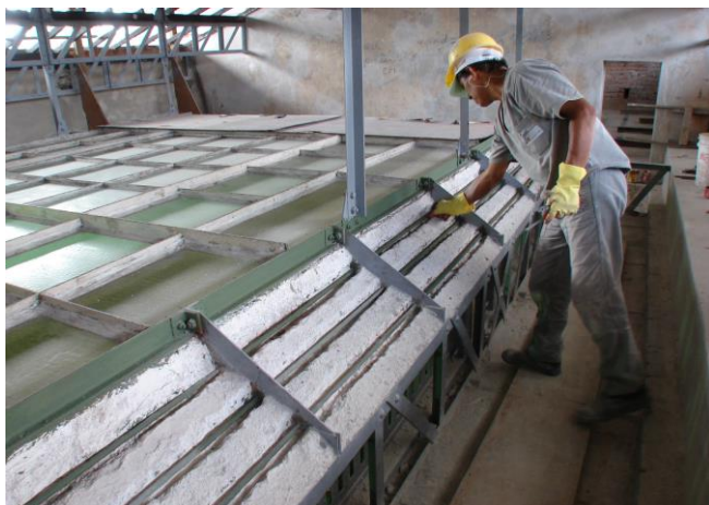
FOTO 78 REINTEGRAÇÃO DO SUBSTRATO DO FORRO - INTRADORSO.
