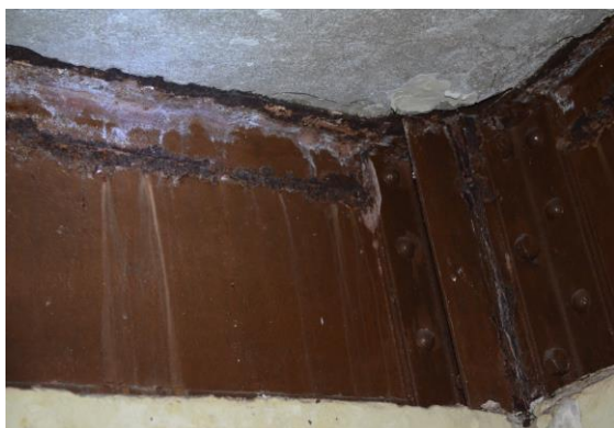
FOTO 134 DETALHE DA ESCADA E PARTE DA ESTRUTURAMETÁLICA DE SUSTENTAÇÃO DO CAMPANÁRIO NO 5º PAVIMENTO – SITUAÇÃO ATUAL.
