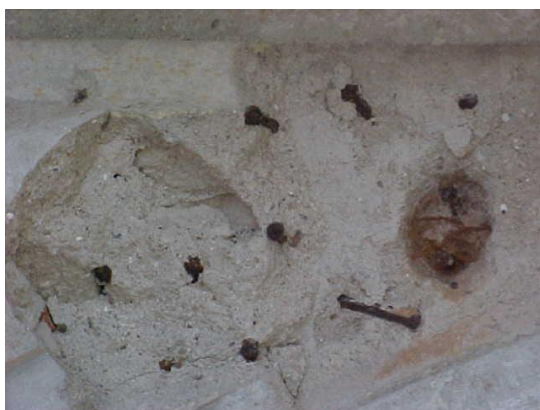
FOTO 124 ESCARIFICAÇÃO, DESOXIDAÇÃO PROTEÇÃO ANTICORROSIVA DOS PINOS E GRAPAS PRESENTES NAS ARGAMASSAS EXTERNAS.
