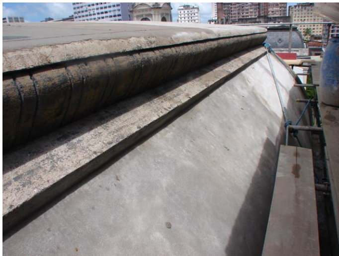
FOTO 100 REGULARIZAÇÃO DO SUBSTRATO DA ABÓBADA.
