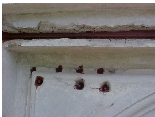
FOTO 124 ESCARIFICAÇÃO, DESOXIDAÇÃO PROTEÇÃO ANTICORROSIVA DOS PINOS E GRAPAS PRESENTES NAS ARGAMASSAS EXTERNAS.
