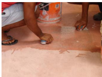
FOTO 87 LIMPEZA, LIXAMENTO E REINTEGRAÇÃO DAS LACUNAS.
